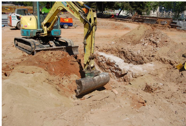
Foto 1. Obertura mecànica del sondeig.
